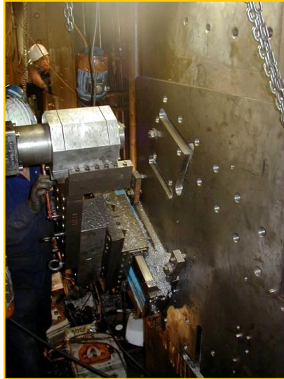
Фрезеровка пазов
