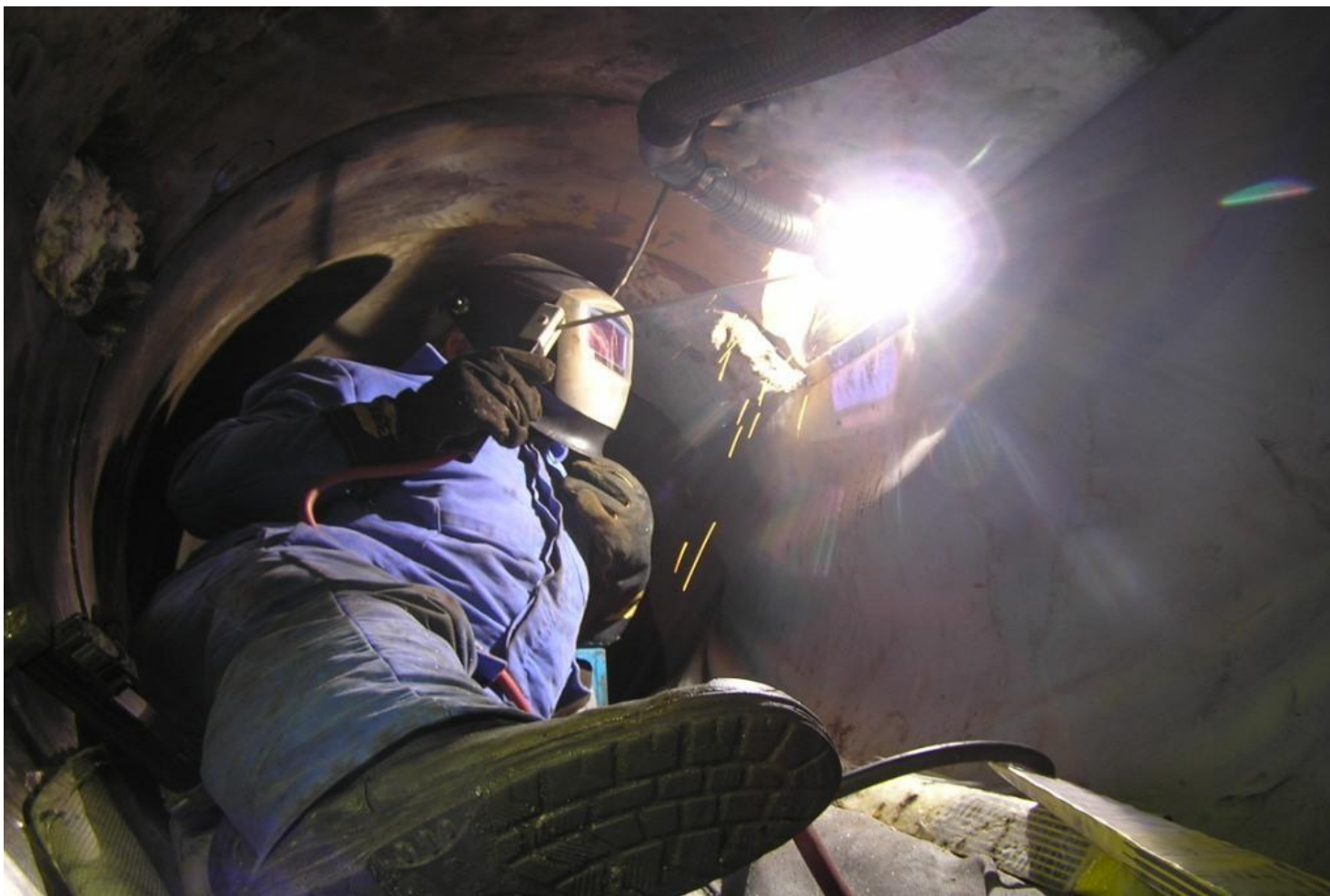
Ремонт цилиндра
