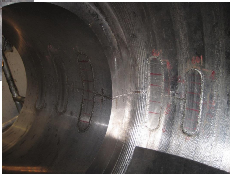
Закреплённые Мастерлоки и готовый ремонт Мастерлок.
