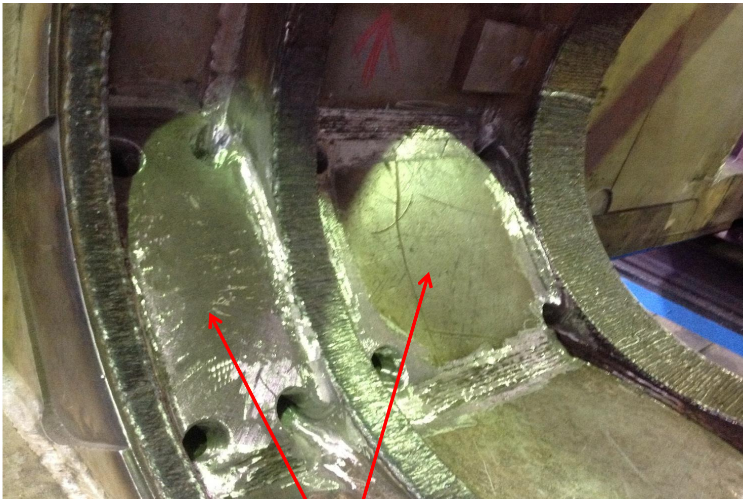
Новые приваренные армирующие элементы
