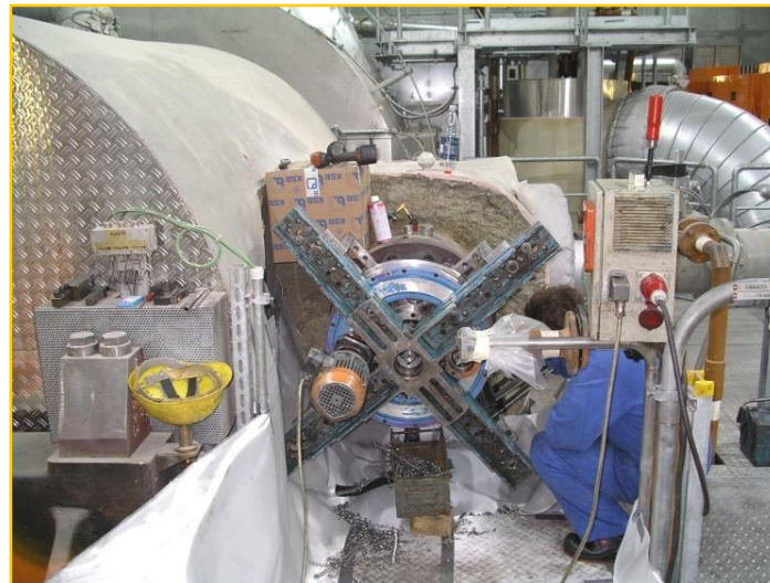
Механическая обработка клапанов
